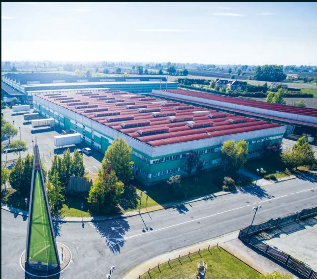
Sito logistico a Rolo (RE)
